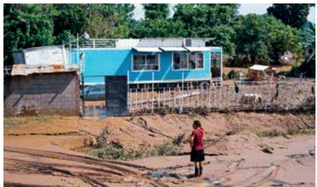
Ganze Dörfer waren im Norden des Landes überschwemmt. Als das Wasser wich, begann der mühevollen Wiederaufbau.
