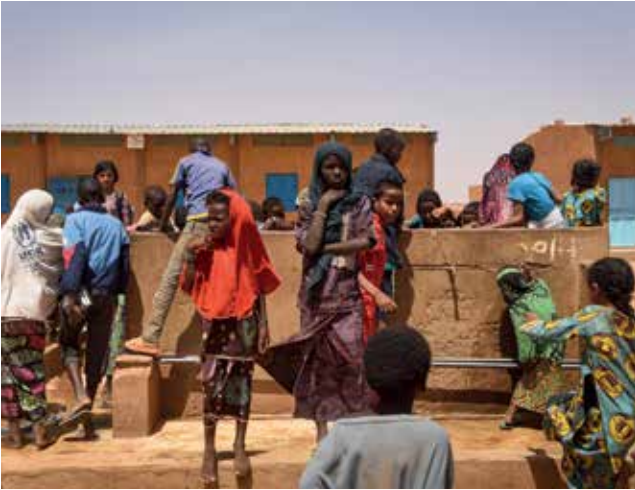
Auch zahlreiche geflüchtete Kinder besuchen die Grundschule in Intikane. Hier hat der ASB Latrinen gebaut und Wasserleitungen verlegt.
