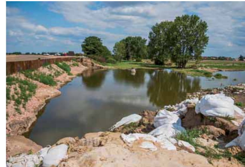
Die Deichbruchstelle: Hier bahnten sich die Wassermassen Anfang Juni ihren Weg Richtung Fischbeck.
