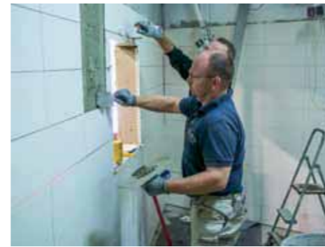
HELP finanziert den Wiederaufbau der Küche.
